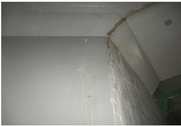
내부 벽체 누수흔적 ( A=0.1\text{m}\times0.1\text{m} )
