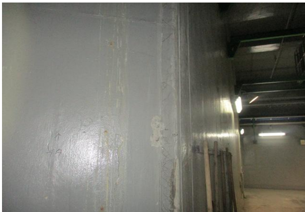
내부 벽체 파손 ( A=0.1\text{m}\times0.2\text{m} )
