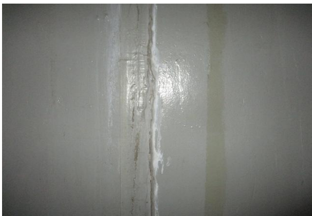
내부 벽체 이음부 이격 ( L=4.0\text{m}\times2\text{EA} , t=0.5\text{cm} )
