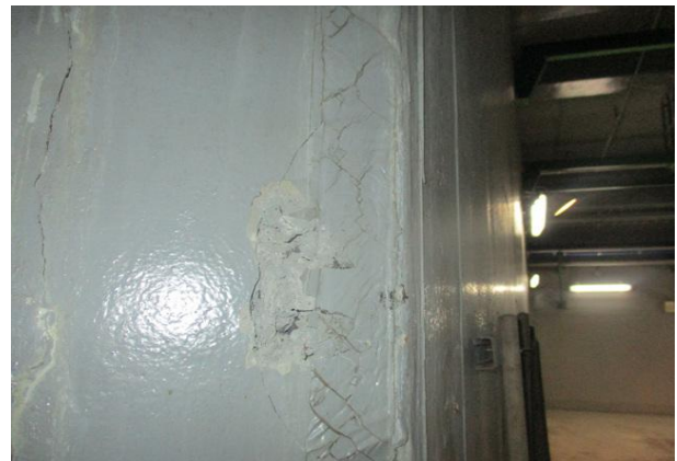
내부 벽체 파손 ( A=0.1\text{m}\times0.2\text{m} )
