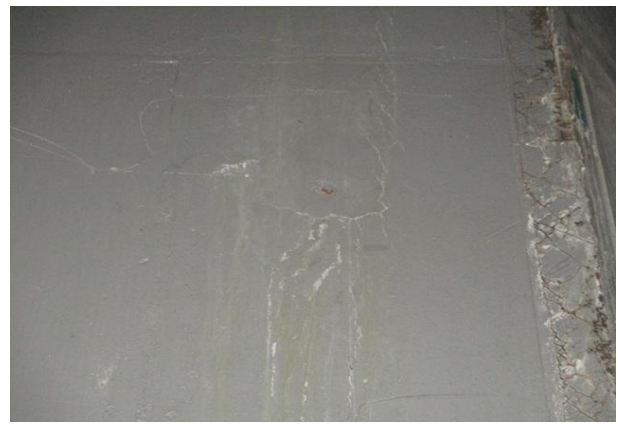
내부 벽체 누수흔적 ( A=0.1\text{m}\times0.1\text{m} )
