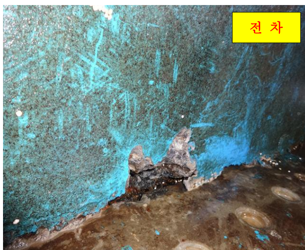
“E” 내부 벽체와 스트레이너 블록 연결부 박락 및 여재 유출 -보수완료-
